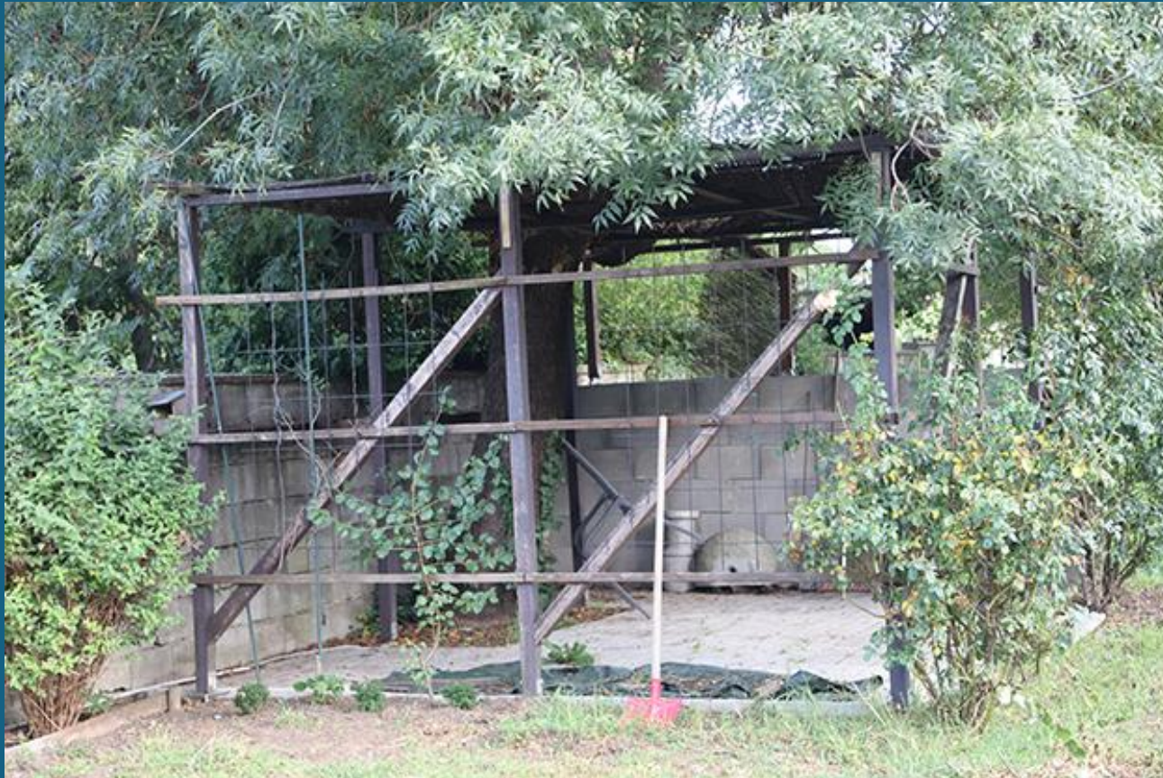
Gartenlaube noch in Bau
